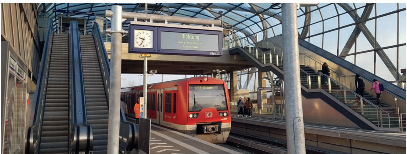
Die Station Elbbrücken – der neue Umstieg in Hamburg.
