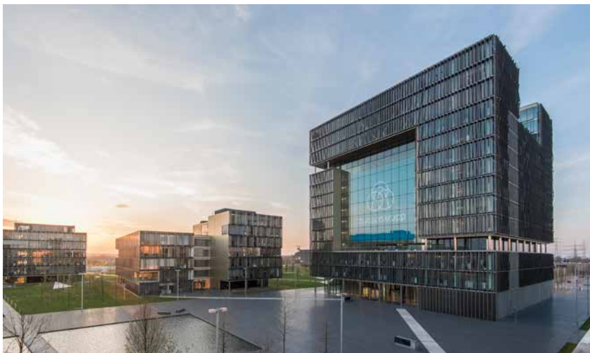
Firmensitz der ThyssenKrupp Electric Steel Europe AG.
