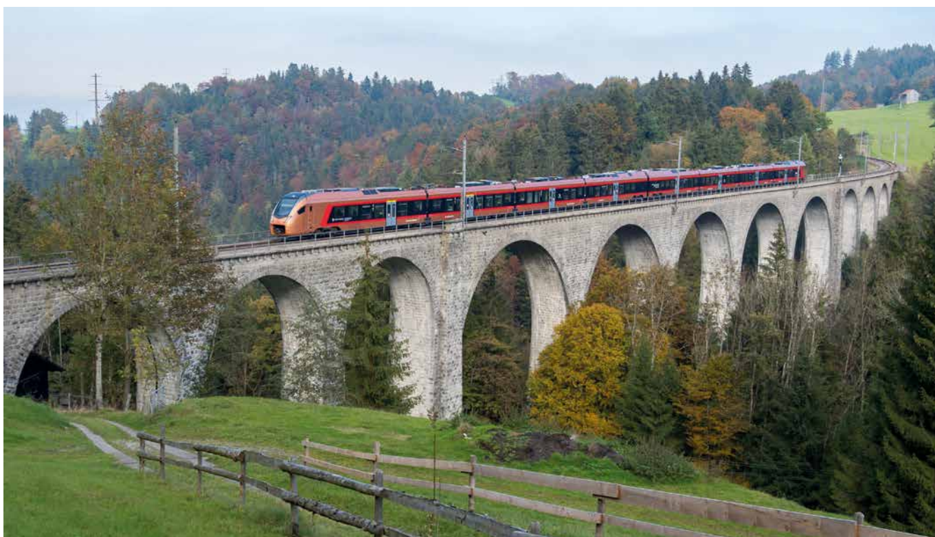
Zug der SOB überfährt das Weissenbach-Viadukt in der Ostschweiz.
